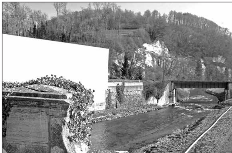
Vue du pont CFF et de la Broye depuis la borne de l'époque bernoise qui est sur le pont routier Vulliens-Moudon
