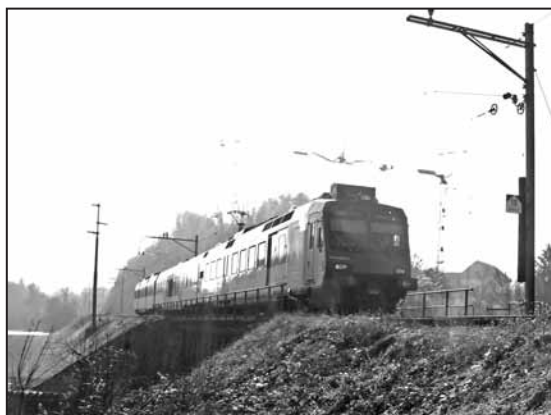
Le train sur le pont qui va être changé
